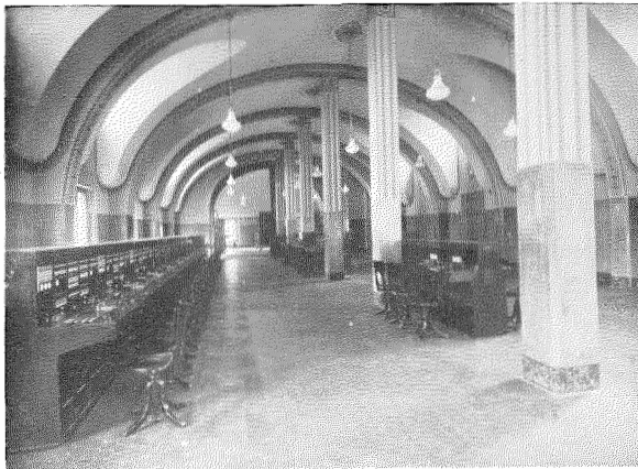
Toll Office—Telefoni Italia Medio Orientale, Bologna
